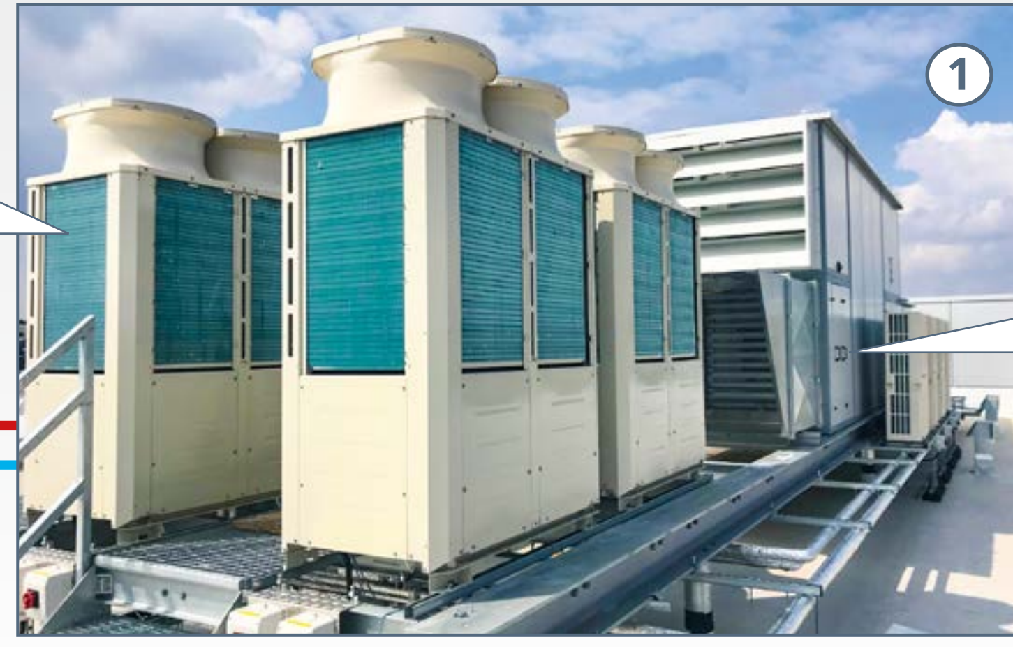
Wärmepumpen / Außeneinheit VRF Mitsubishi Electric – City Multi (saisonale Effizienz).
